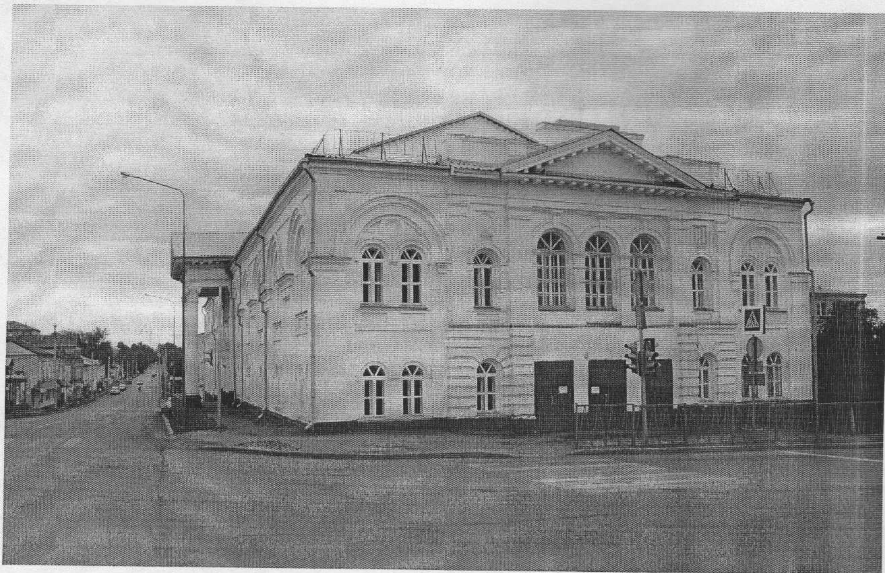
Вид с севера на северный фасад
